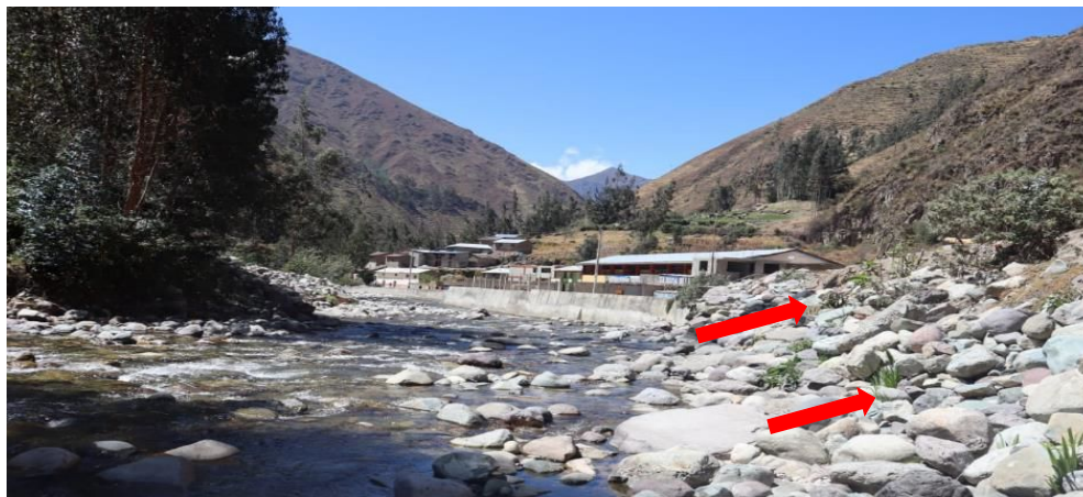
FIGURA N°02: SE OBSERVA QUE EXISTE UN SOLO MURO DE CONTENCION QUE ES INSUFICIENTE PARA CONTENER UN INCREMENTO DE CAUDAL DEL RIO ULCUMAYO (RIO MACHO), YA HA OCURRIDO UNA VES SE HA DESBORDADO EL RIO Y HA AFECTADO VIVIENDAS.
